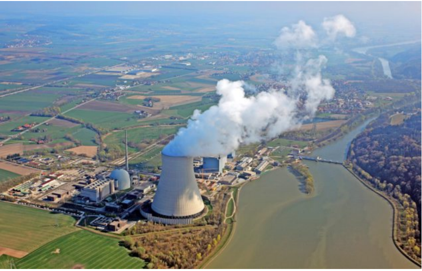
Das Kernkraftwerk Isar 2 ist seit 1988 in Betrieb. Foto Imago
